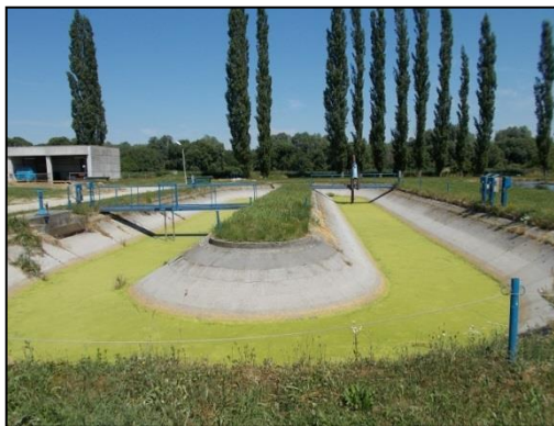
Üzemen kívüli kiegyenlítő:
