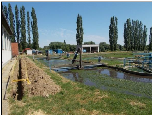
Utóülepítők (oxidációs technológia részeként): Fertőtlenítő műtárgy:
