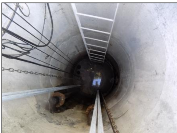
BH-1 j. átemelő akna
