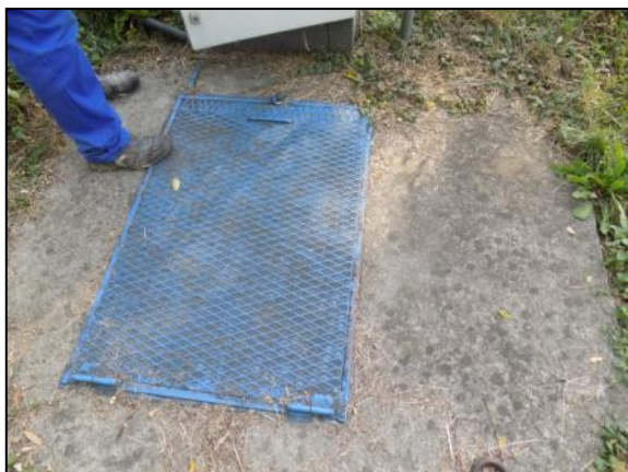
Bem utcai átemelő akna
