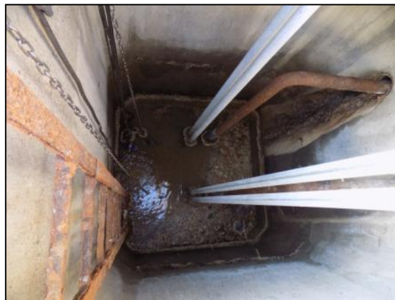
Hunyadi utcai átemelő akna
