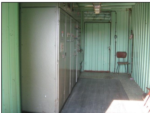
Nyomásfokozó- villamos konténer belső
