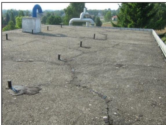
Rózsa u. térszíni tároló tetőszigetelés
