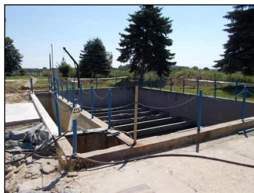
Utóülepítők (oxidációs technológia részeként): Fertőtlenítő műtárgy:
