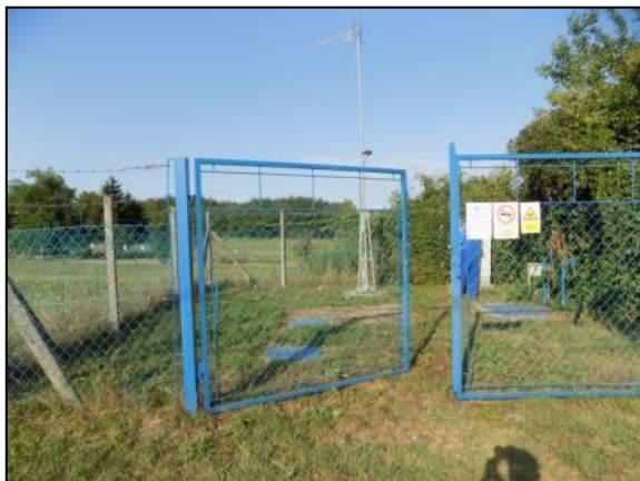
BH-1 j. átemelő környezete
