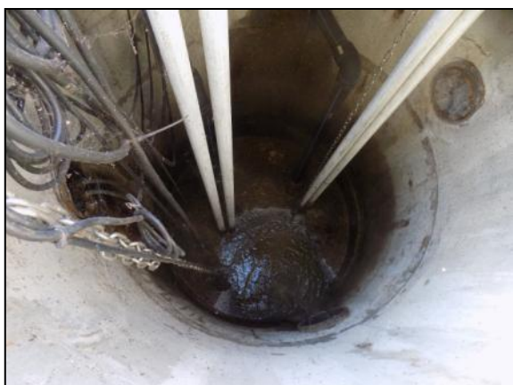
Jókai Mór utcai átemelő akna
