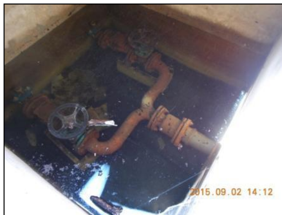
Ipari Park átemelő szerelvényakna
