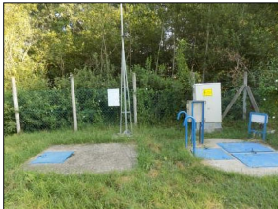
R-1 j. átemelő műtárgyak
