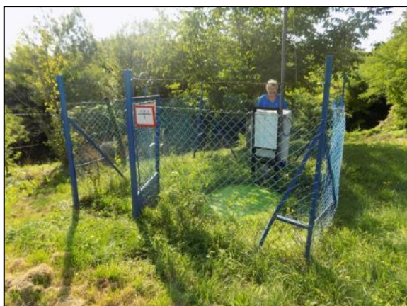
Kodály Z. utcai átemelő környezete
