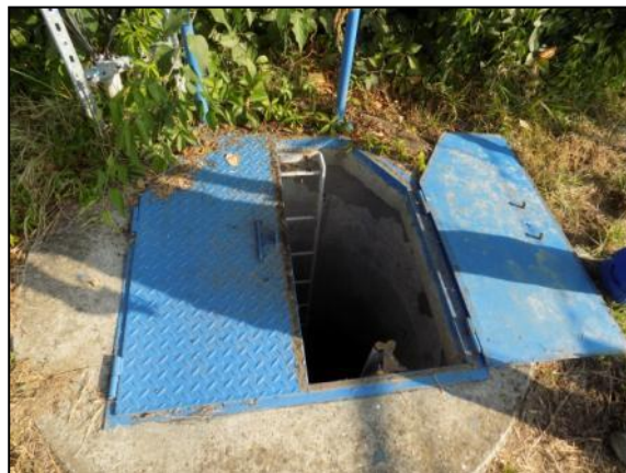
BH-1 j. átemelő akna
