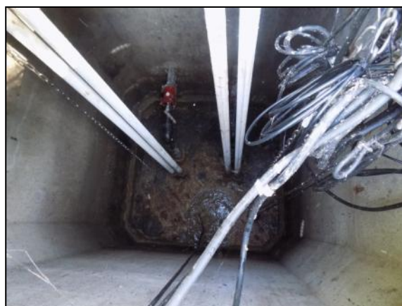
Bem utcai átemelő akna
