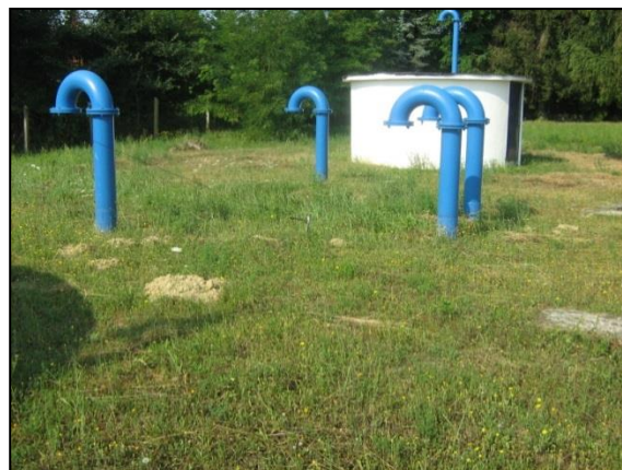
Szőlőhegy iker tároló tető felépítmény
